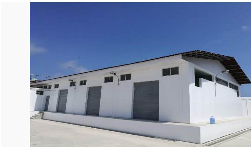
Vista panorámica de la Sala de Tareas Previas del DPA Puerto Pizarro.
