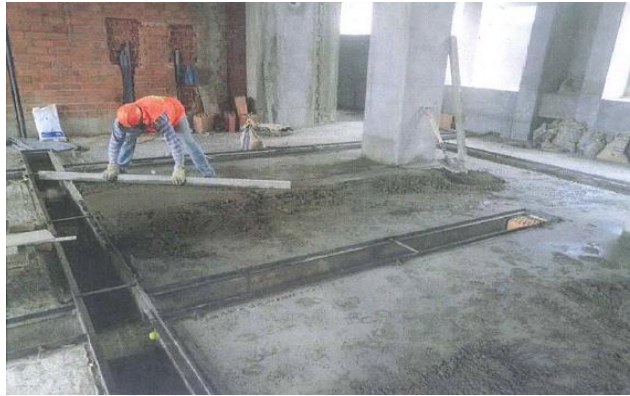
vaciado de falso piso en tareas previas.
