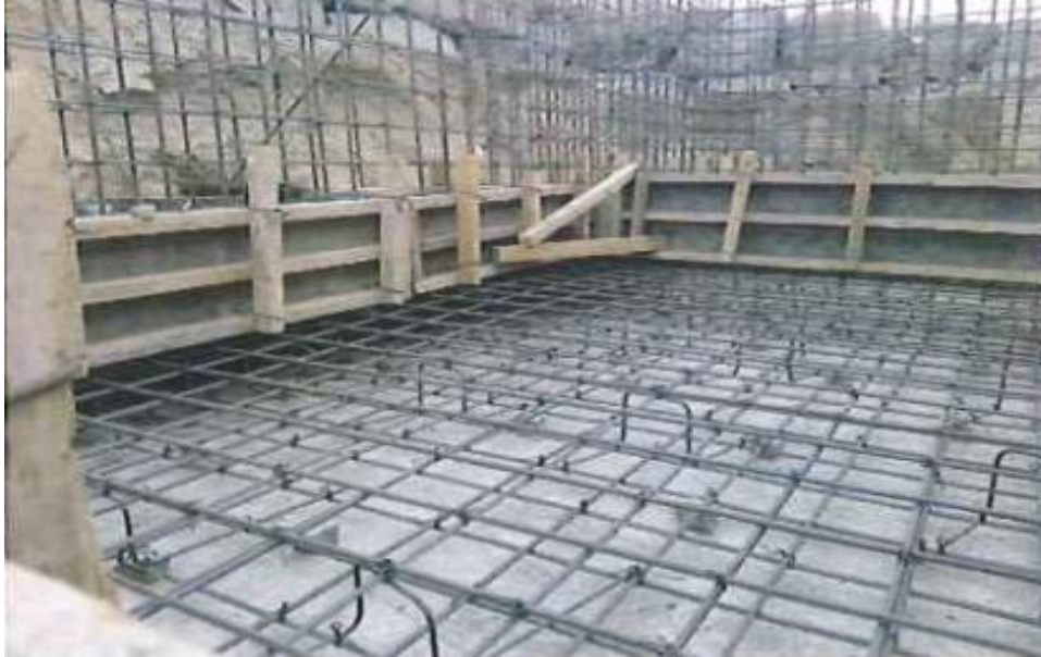
Tanque Séptico armado de acero de refuerzo.
