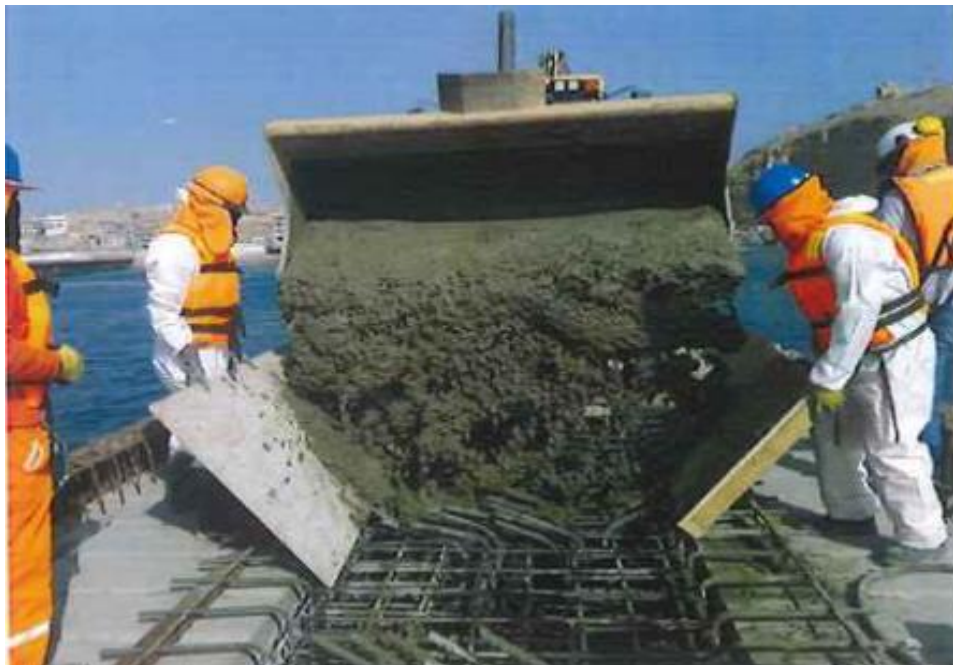
Muelle: Vaciado de 1er Núcleo.
